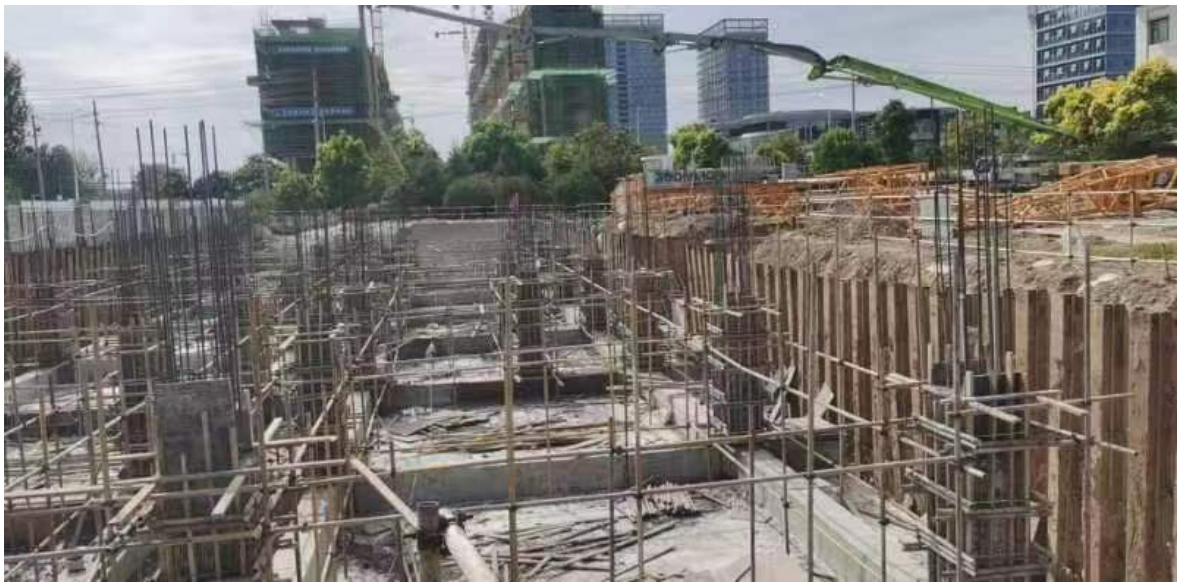
图 2.2-4 教学楼现场照片
