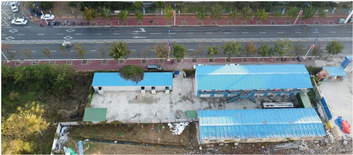
图 2.3-1 临时项目区现场照片
